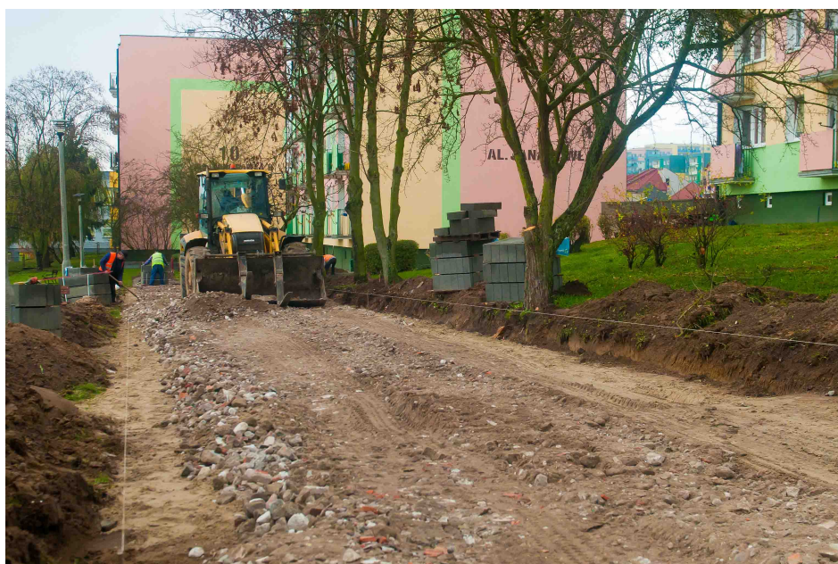
Budowa pieszojezdni między blokami nr 12 i 14 przy alei Jana Pawła II a boiskiem „Orlika”
