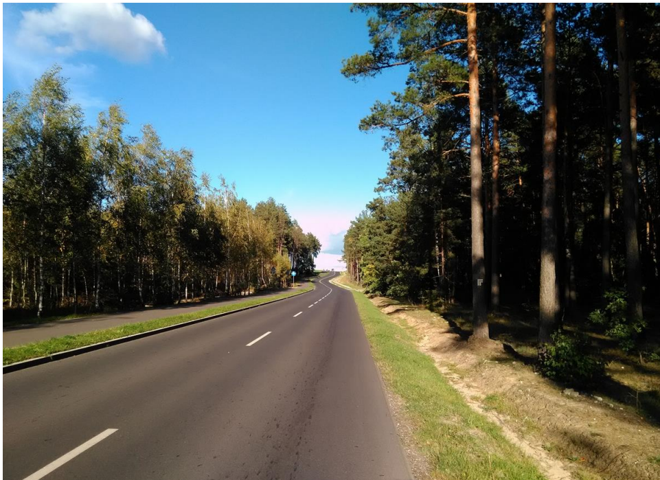
Droga w Sulnówku
