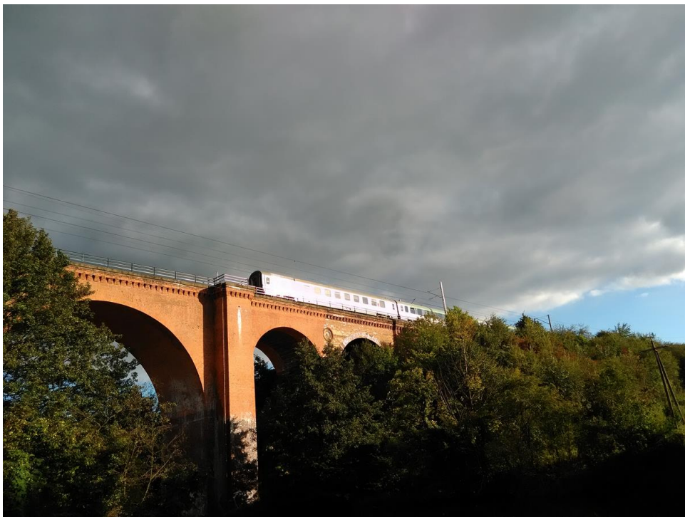
Most kolejowy w Kozłowie
