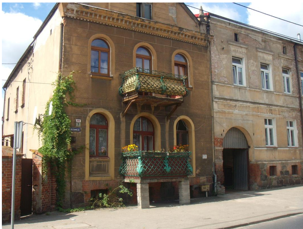
Budynek przy ul. Mickiewicza 1
