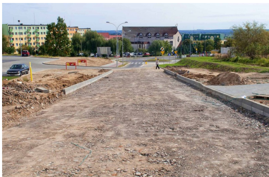
Nowo budowana ul. Sobieskiego
