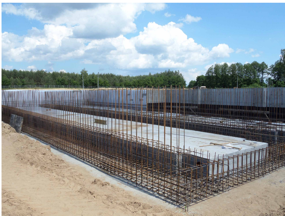
Tu powstaje hala stabilizacji odpadów
