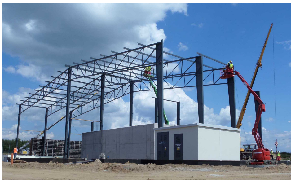
Montaż konstrukcji hali sortowni
